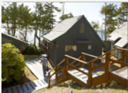
— Cabin van de buitenkant —
